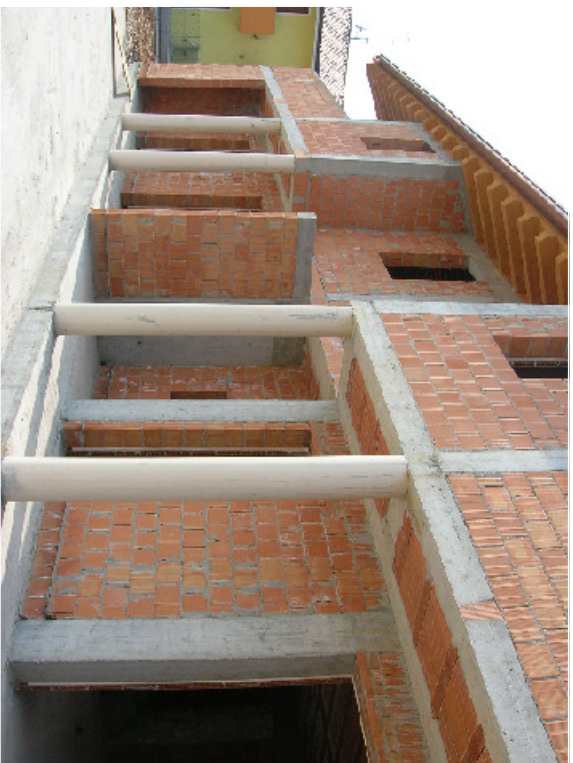
Dettaglio vista da sud-est
